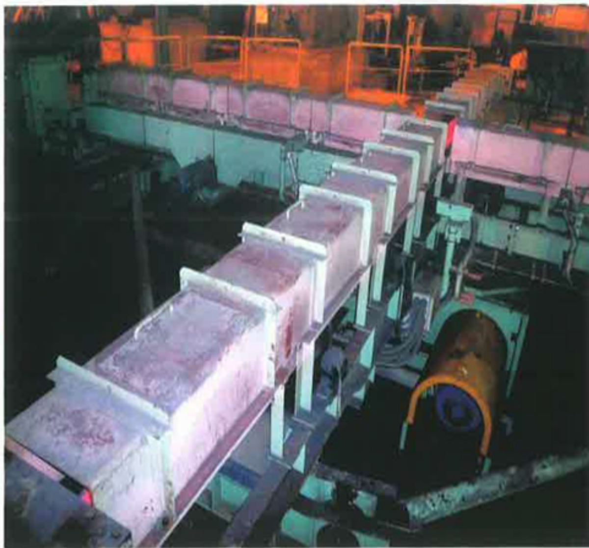
鋼片搬送設備(ターンテーブル) / Slab and billet transfer (Turning transfer device)
